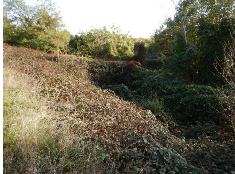
2 ème ouvrage de gestion des EP, à l'Est du site.
